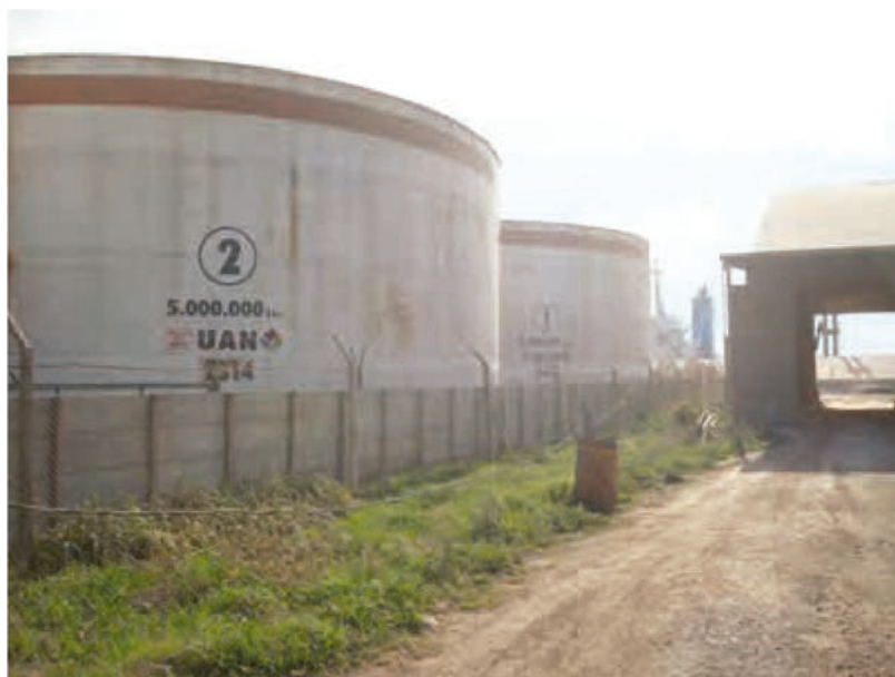
Figura 3. Tanques de almacenamiento primario para UAN en terminales portuarias.
